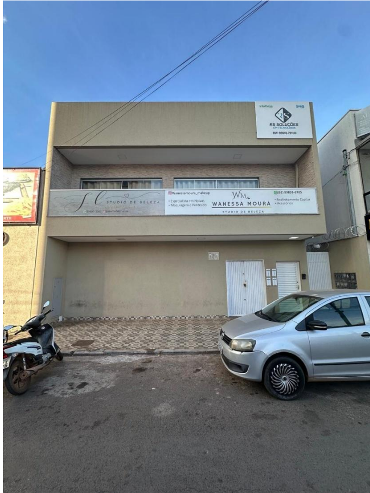
Figura 1: Fachada do prédio em que se situam as empresas
