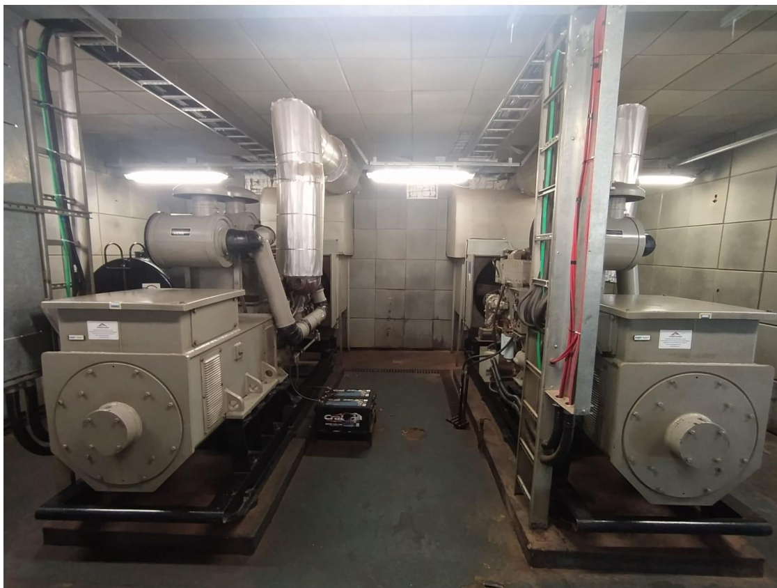
Figura 7 - Vista dos geradores e sistema de descarga a substituir
