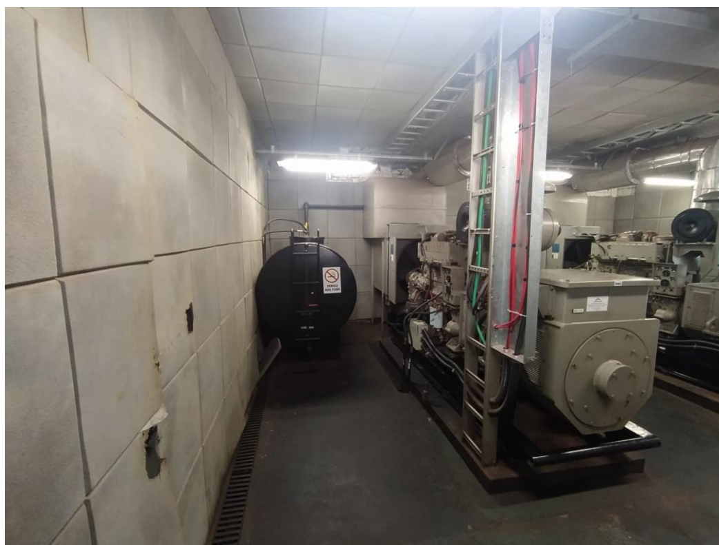
Figura 5 - Tanque de combustível externo deverá ser esvaziado, limpo e transportado para local apontado pela fiscalização.
