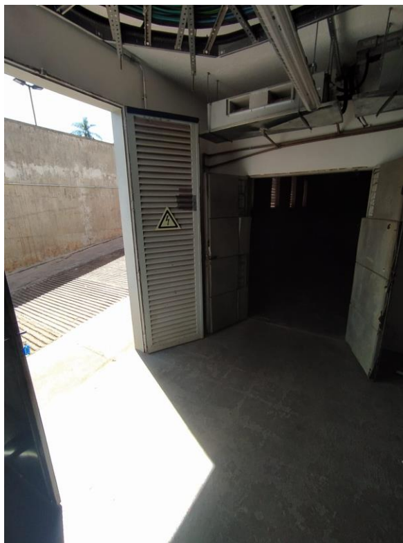
Figura 2 - Porta de acesso a ante sala dos geradores. Observar as dimensões da porta e que, por se tratar de uma cortina de concreto, não é possível a sua ampliação. O modelo de gerador ofertado deve ter dimensão limitada às portas de passagem. Observar ainda que o acesso ao ambiente se dá por meio de rampa inclinada, o que pode dificultar a logística de movimentação das máquinas novas. Porta 1: 1,45 (L) x 2,50 (A) Porta 2: 1,45 (L) x 2,05 (A).
