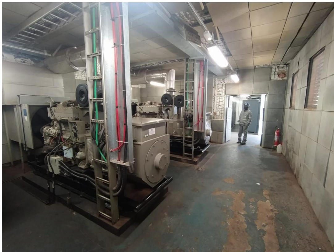
Figura 4 - Vista da sala dos geradores. Observar que a infraestrutura entre os geradores e a USCA e a infraestrutura entre a USCA e CTA deverão ser mantidas. Eventuais necessidades de complementação de eletrodutos e eletrocalhas correrão às expensas da contratada.
