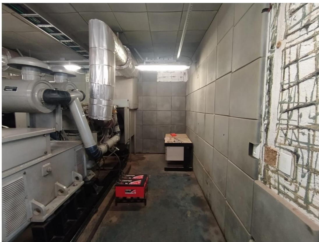
Figura 8 - Revestimento acústico a remover
