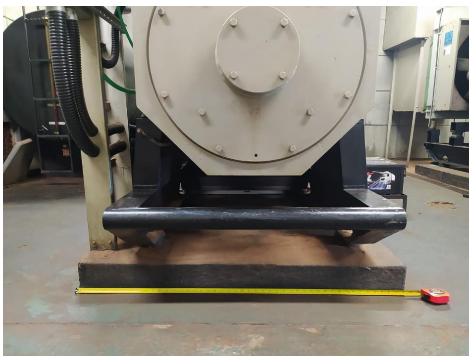
Figura 1 - Base de concreto existente no interior da sala de geradores
