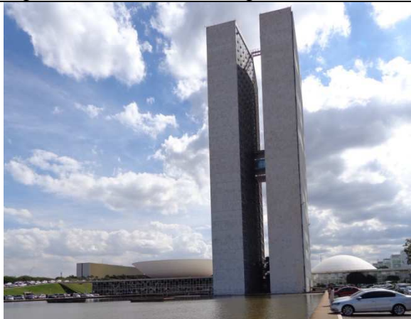
Figura 1 - Anexo 01 - Fachada Leste
