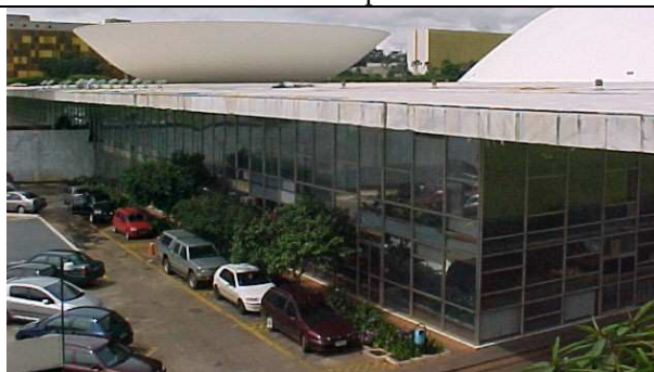
Figura 10 - Edifício Principal - Fachada Leste. Trecho.
