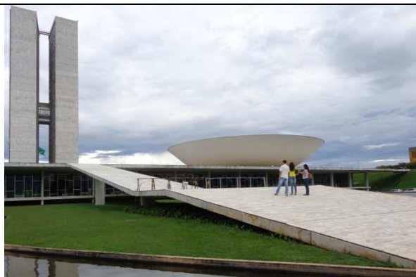
Figura 22 - Rampa do Edifício Principal - Vista geral
