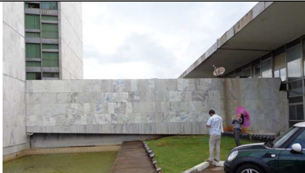
Figura 7 - Túnel do Edifício Principal - Fachada Norte
