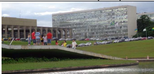
Figura 23 - Rampa do Edifício Principal - Vista geral
