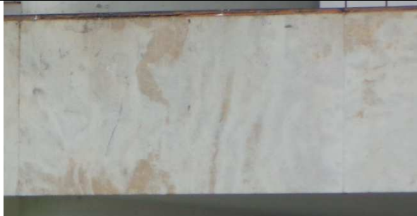
Figura 18 - Edifício Principal - Exemplo de mármore aplicado
