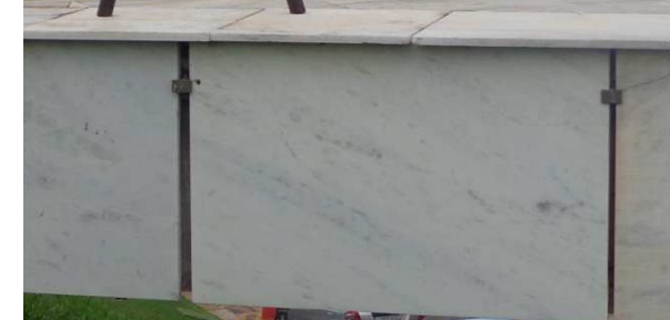
Figura 16 - Edifício Principal - Exemplo mármore aplicado
