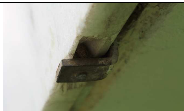
Figura 20 - Edifício Principal - Encaixe Inferior das peças
