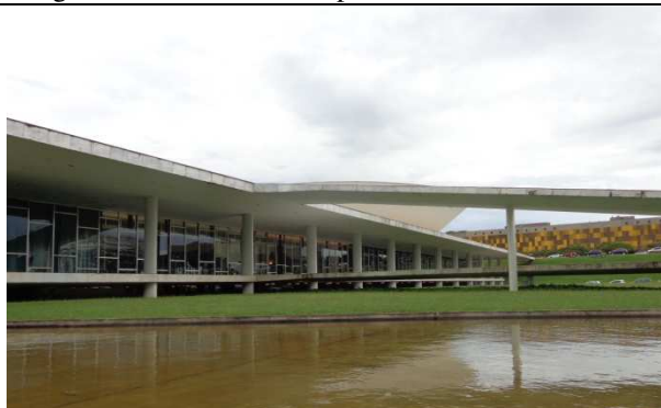
Figura 12 - Edifício Principal - Fachada Oeste
