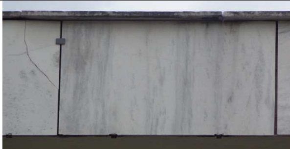
Figura 17 - Edifício Principal - Exemplo de mármore aplicado
