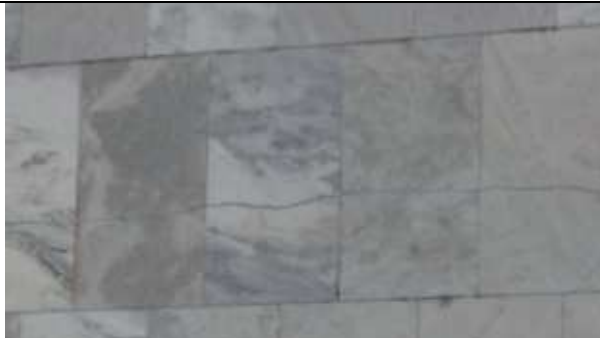
Figura 8 - Túnel do Edifício Principal – Exemplo de
