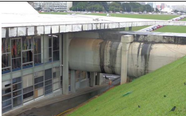
Figura 11 - Edifício Principal - Fachada Norte. Trecho.
