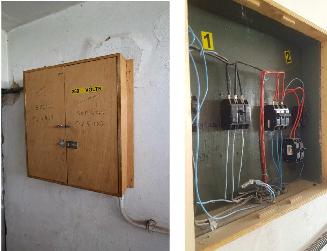
FOTO 21 – Quadro de força, presente em todas as casas de máquinas. Circuitos 1 e 2, fazem a alimentação elétrica da iluminação do elevador e do quadro de comando.
