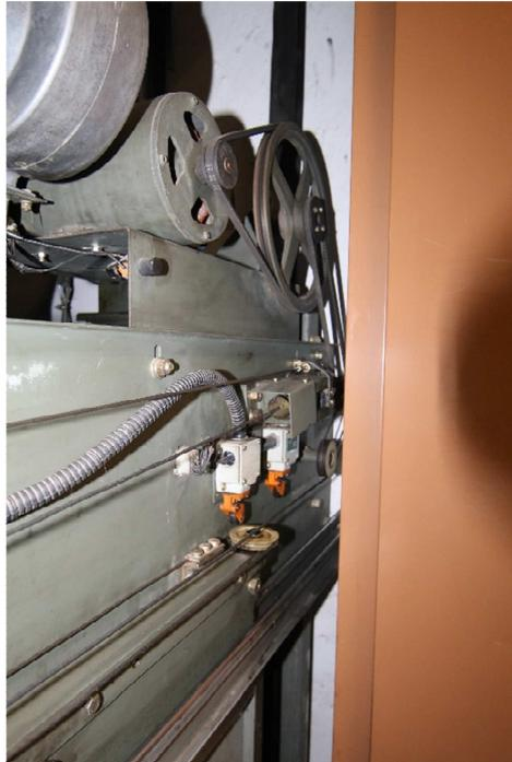
FOTO 19 – Operador de porta. O mecanismo deve ser substituído em todos os elevadores
