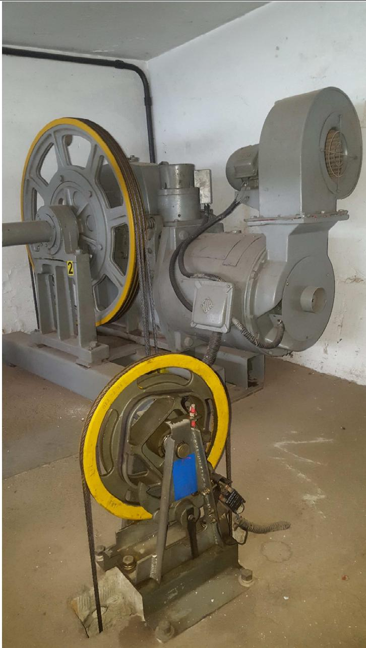
FOTO 25 – Máquina de tração e regulador de velocidade.
