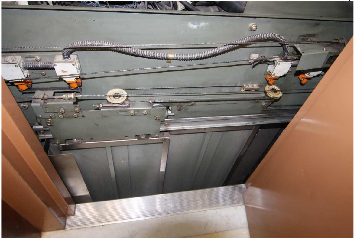
FOTO 20 – Operador de porta. O mecanismo deve ser substituído em todos os elevadores
