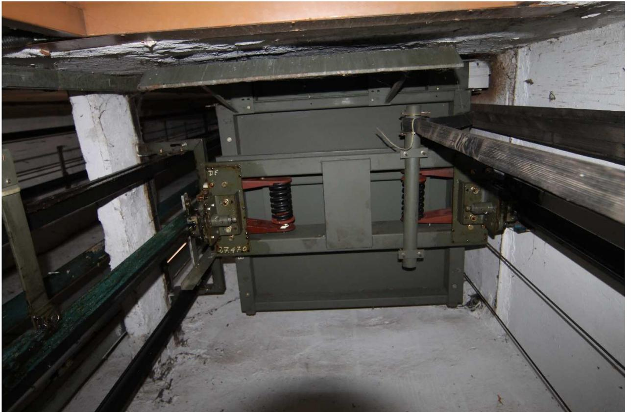
FOTO 5 – Caixa de corrida. Detalhe, inferior da cabine
