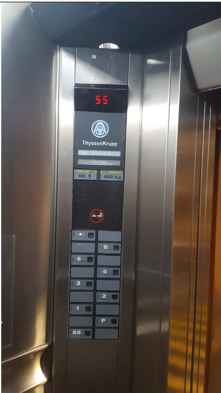
FOTO 16 – Conjunto de botoeiras e sinalizadores de cabine do elevador de social. O conjunto, deve ser substituído e mantido na mesma posição de montagem, adequando à altura, conforme normas de acessibilidade.
