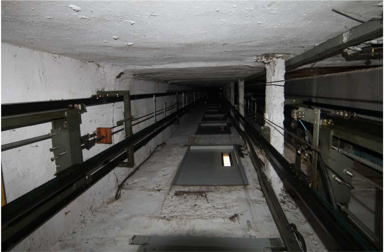
FOTO 3 – Caixa de corrida do elevador. Deverá ser previsto iluminação ao longo da caixa e instalação de luminárias de emergência, de acordo com normas vigentes aplicáveis.
