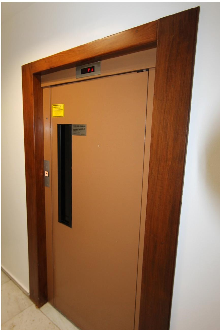
FOTO 18 – Conjunto botoeiras e sinalizadores de pavimento, elevadores de serviço. Deverá ser previsto a substituição das botoeiras e sinalizadores, adequando-os às normas de acessibilidade.
