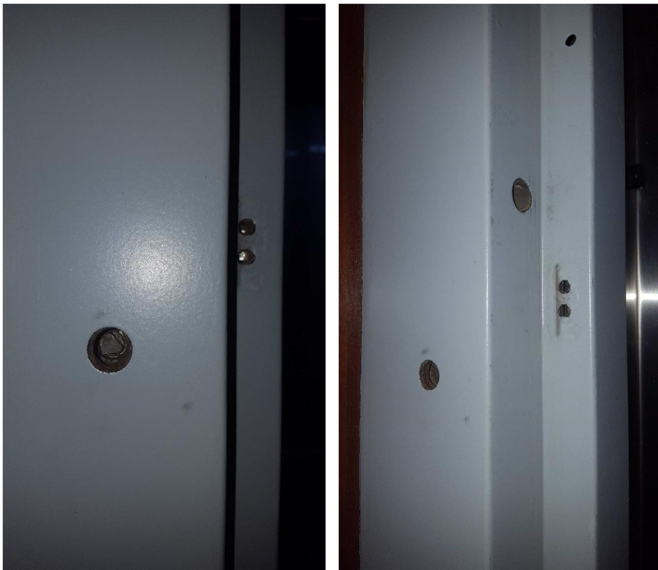
FOTO 11 – Detalhe, trava de abertura da porta de pavimento, nos elevadores de serviço. Esse mecanismo deve ser substituído por outro, que dificulte a abertura por leigos
