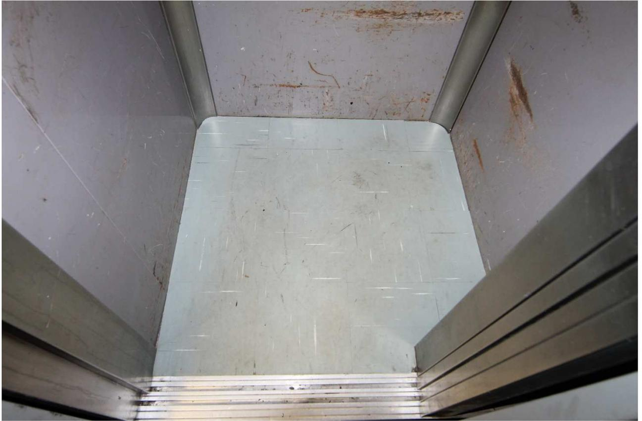
FOTO 7 – Interior dos elevadores de serviço. Piso Paviflex a ser substituído.
