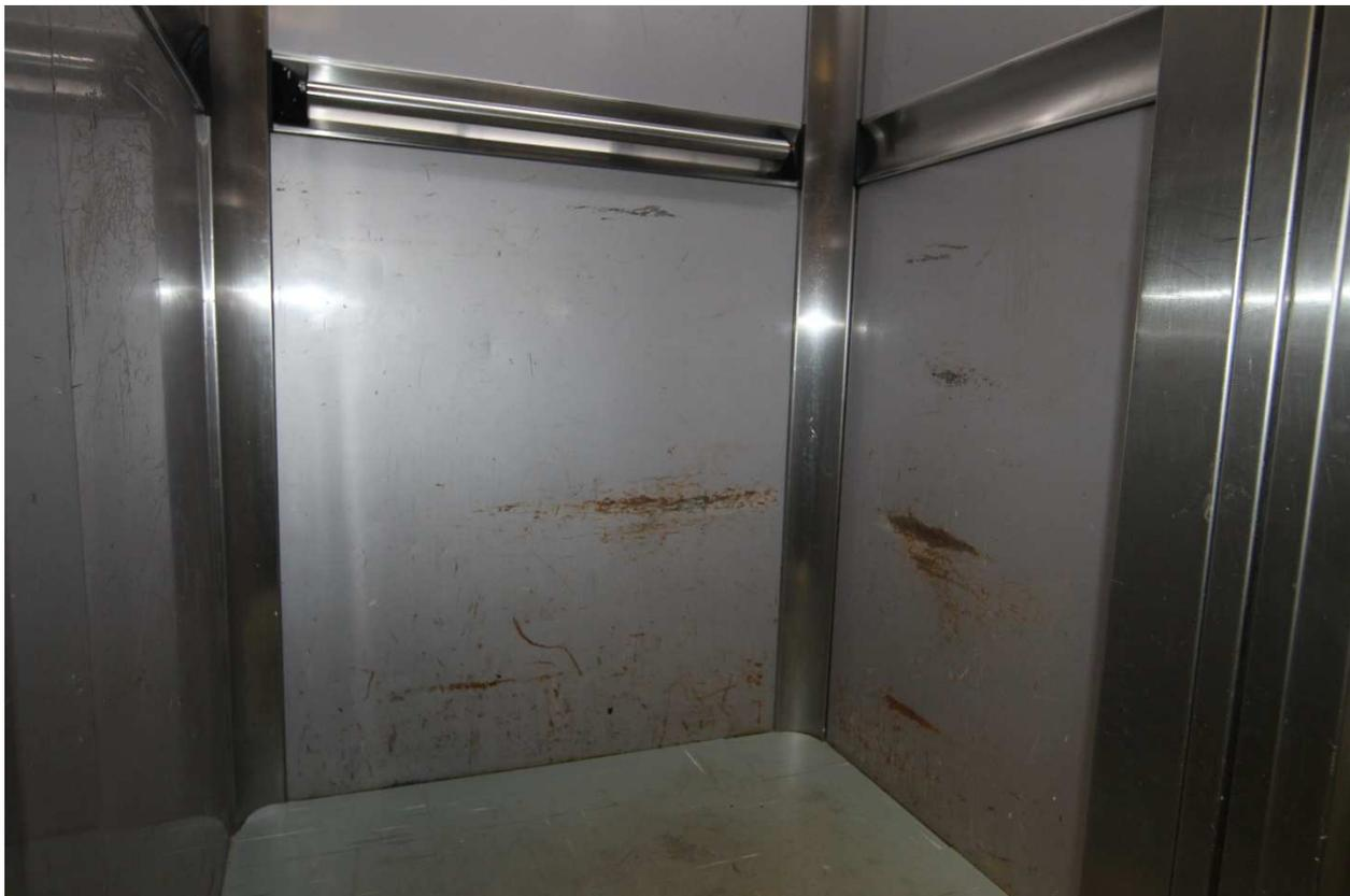
FOTO 8 – Interior dos elevadores de serviço. Substituição integral do revestimento interno.
