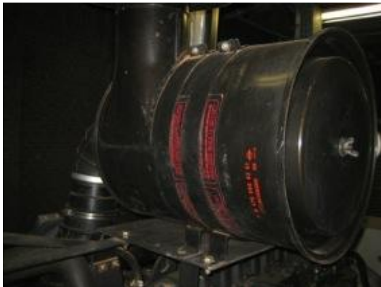
Foto 78: Detalhe do sistema de admissão de ar do motor, mostrando o filtro de ar.
