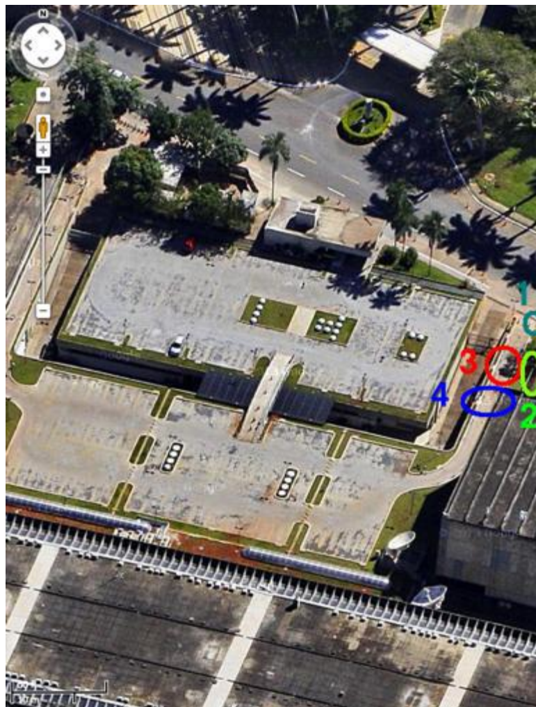
Foto 44: Vista aérea de parte do Edifício do Prodasen, ilustrando (no canto direito) os principais locais do Sistema de Geração de Energia Elétrica de Emergência do Prodasen (fonte: Google Maps – escala no canto inferior esquerdo da imagem). 1 – Entrada de combustível; 2 – Exaustão dos grupos motores-geradores; 3 – Sala dos grupos motores-geradores; 4 – Sala de quadros e no-breaks, local dos quadros de comando, sincronismo e potência dos grupos e da chave de transferência automática.
