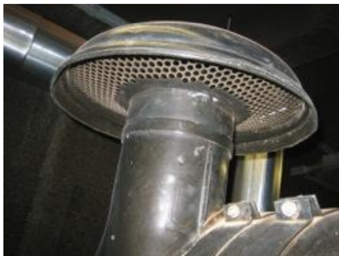
Foto 77: Detalhe do sistema de admissão de ar do motor, próximo ao filtro de ar.
