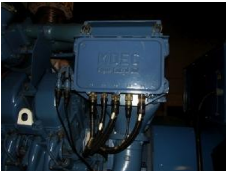
Foto 16: Módulo eletrônico de controle do motor diesel MTU (MDEC) e cabecamentos.
