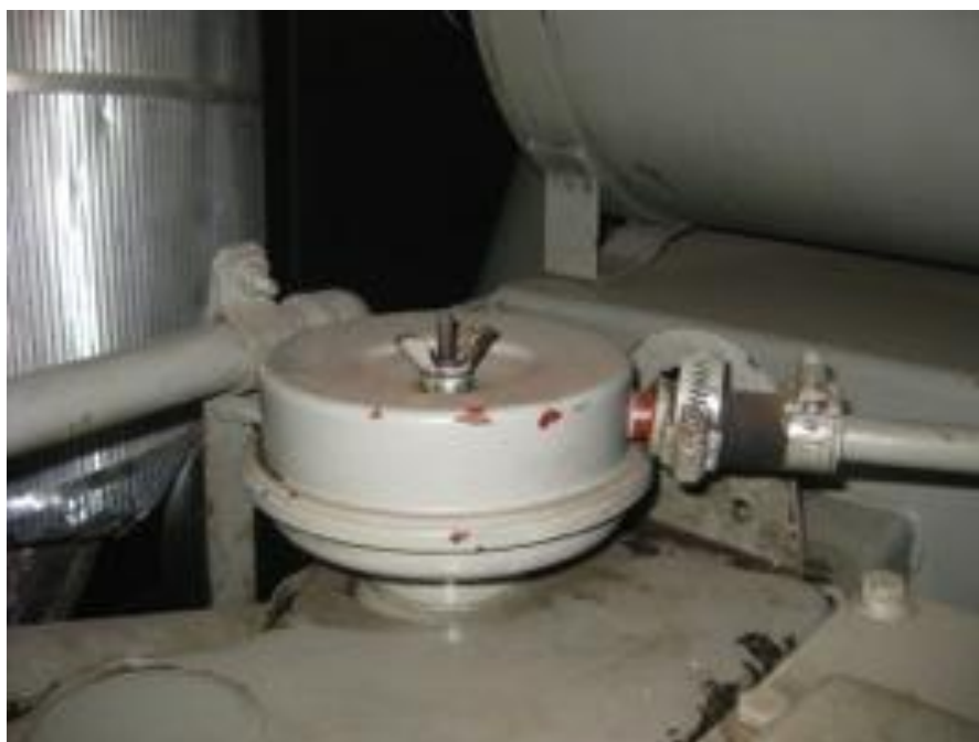
Foto 58: Detalhe o respirador do cárter, localizado na parte superior do motor.
