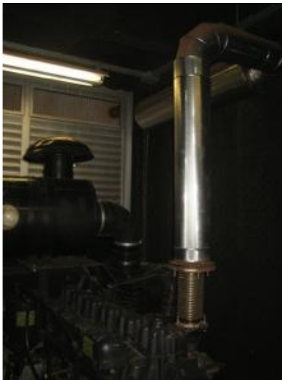
Foto 79: Detalhe do sistema de exaustão do motor, mostrando os dutos de exaustão.
