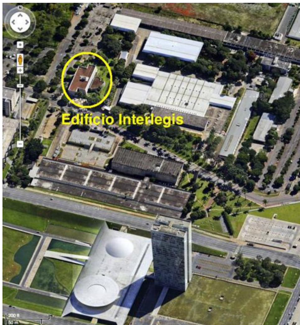
Foto 71: Vista aérea de parte do Complexo Arquitetônico do Senado Federal, ilustrando a posição do Edifício Interlegis, local do Sistema de Geração de Energia Elétrica de Emergência do Interlegis (fonte: Google Maps – escala no canto inferior esquerdo da imagem).
