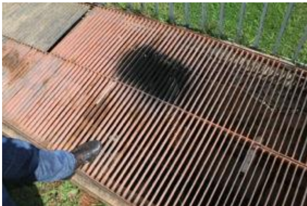
Foto 66: Outra vista da saída de ar de arrefecimento e exaustão dos motores.
