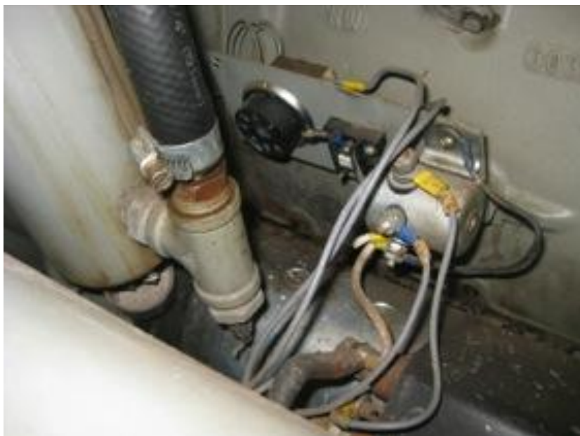
Foto 59: Detalhe do termostato do motor.
