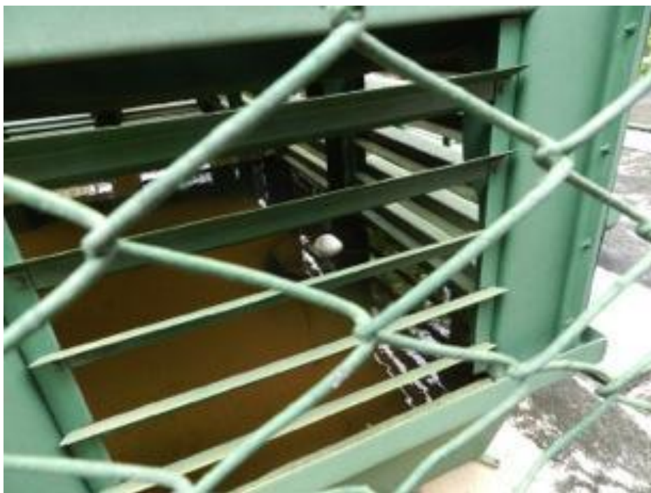
Foto 36: Detalhe interno da torre de resfriamento.
