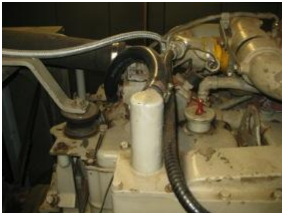
Foto 57: Detalhe da parte superior do motor. Nota-se, à esquerda, os amortecedores do conjunto.
