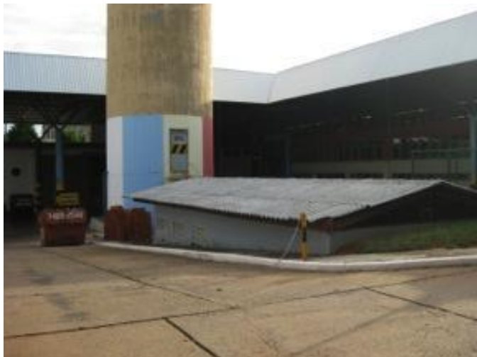
Foto 29: Em primeiro plano, a guarita que abriga o tanque principal de óleo diesel (10.000 litros), os tanques de diesel filtrado, o filtro prensa, a bomba de transferência de combustível, o quadro de comando e demais acessórios do sistema de combustível do Sistema de Geração de Energia Elétrica de Emergência Geral do Senado Federal.
