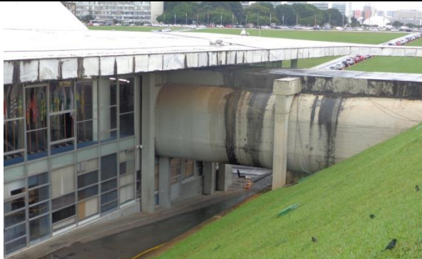
Figura 11 - Edifício Principal - Fachada Norte. Trecho.
