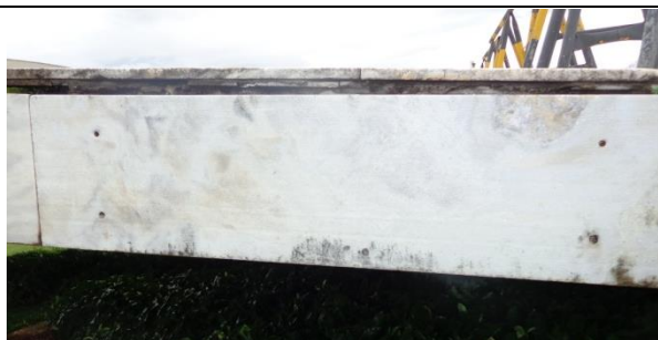
Figura 25 - Rampa do Edifício Principal - Exemplo de mármore aplicado
