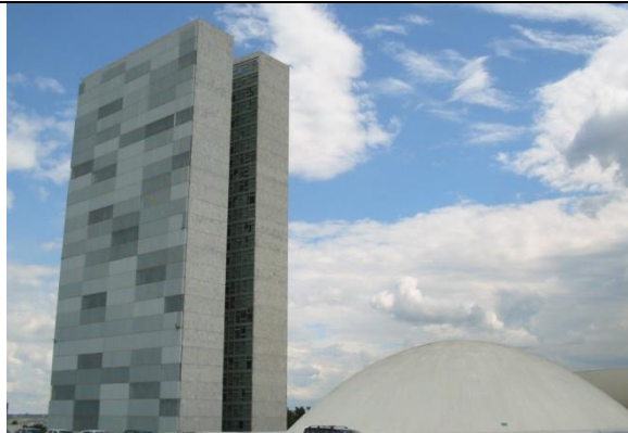
Figura 3 - Anexo 01 - Fachada Oeste
