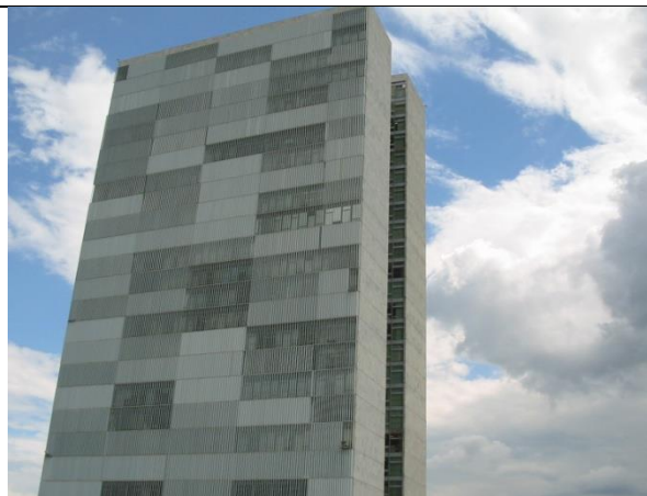
Figura 2 - Anexo 01 - Fachada Norte
