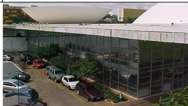
Figura 10 - Edifício Principal - Fachada Leste. Trecho.
