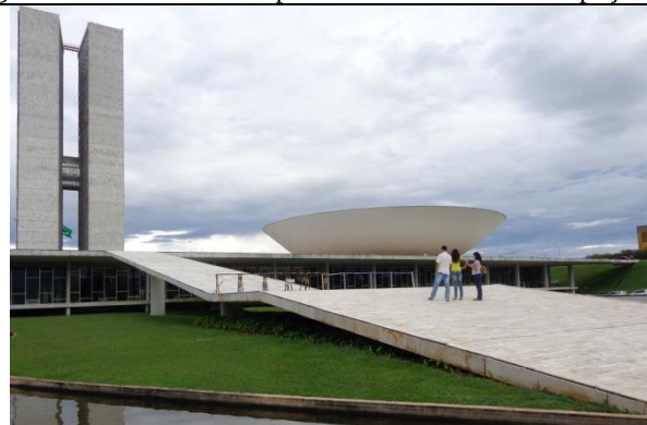
Figura 22 - Rampa do Edifício Principal - Vista geral
