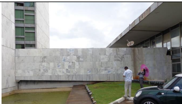
Figura 7 - Túnel do Edifício Principal - Fachada Norte
