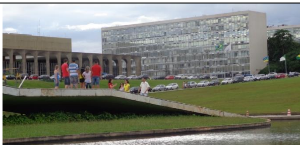
Figura 23 - Rampa do Edifício Principal - Vista geral
