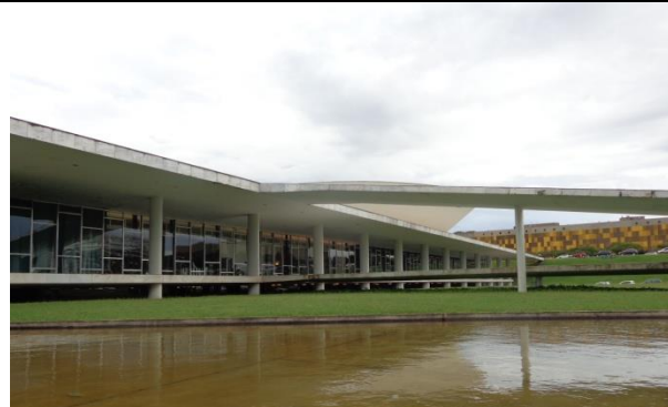
Figura 12 - Edifício Principal - Fachada Oeste
