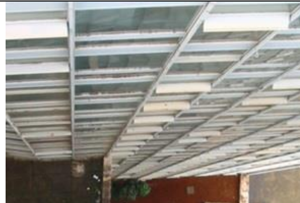
Figura 4 - Anexo 01 - Fachada Sul. Trecho.
