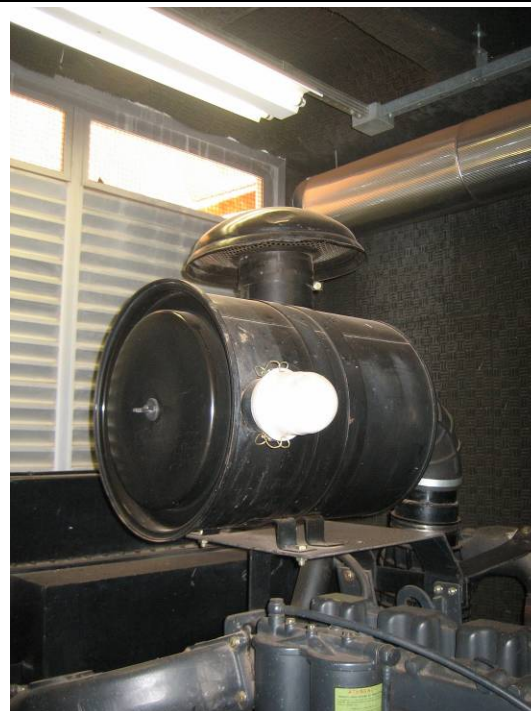
Detalhe do filtro de ar do motor.
