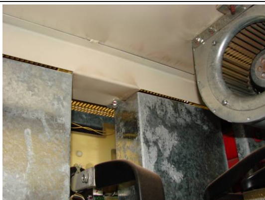
3x GE SitePro 135kVA. Ventilador centrífugo e mais duas saídas de ar de outros ventiladores centrífugos não mostrados na foto.
