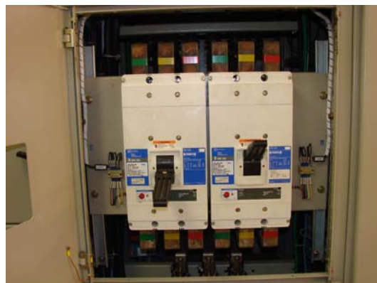
Detalhe da chave de transferência manual.
