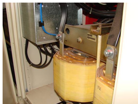
GE SitePro 135kVA. Transformador interno ao gabinete.
