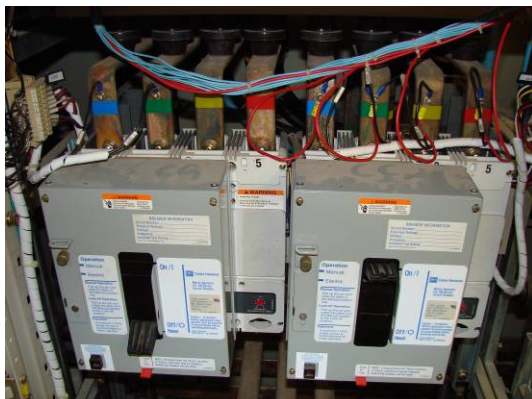
Chave de transferência automática marca Cutler-Hammer. Type LD/MDL / CAT EOP4MT11A
