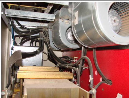
GE SitePro 80kVA. Observe os ventiladores centrífugos.
