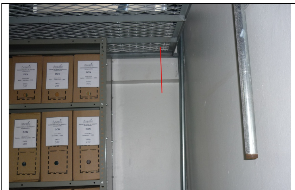
Figura 8. Posição da tubulação de água gelada na Secretaria de Arquivo.
