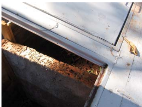
2) Detalhe da armação metálica
