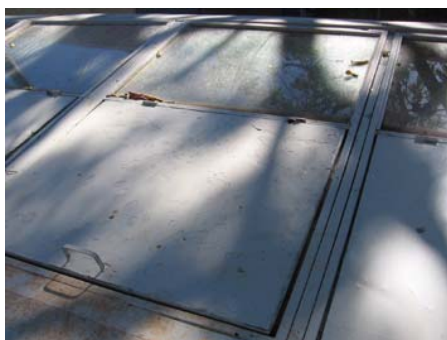
3) Detalhe da tampa de chapa e vidro
