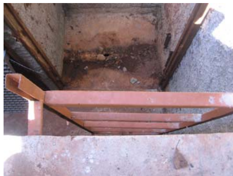
9) Escada de acesso à câmara do composto
