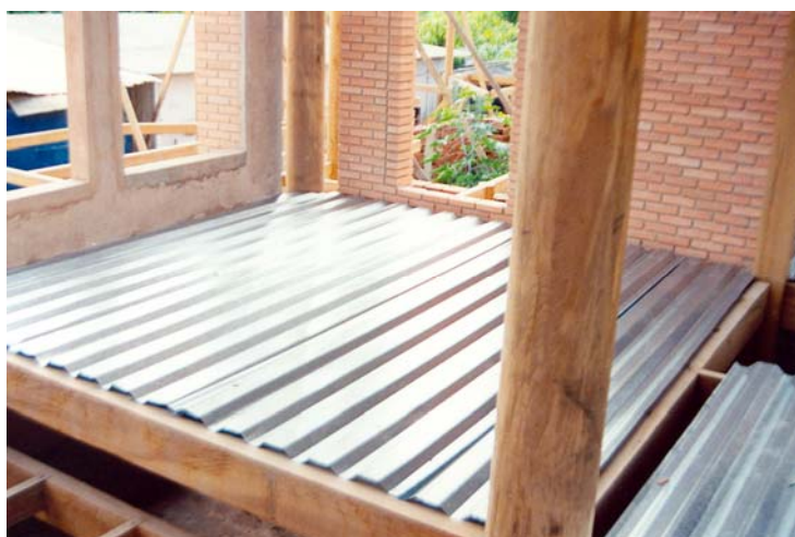
2) Telha metálica simplesmente apoiada
