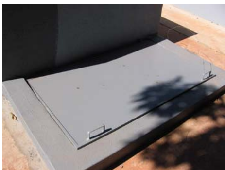
6) Detalhe da tampa da câmara de xorume
