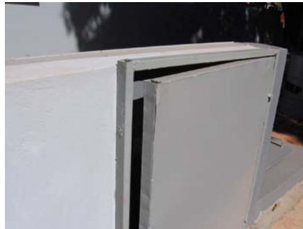
7) Detalhe da portinhola de acesso à câmara do composto
