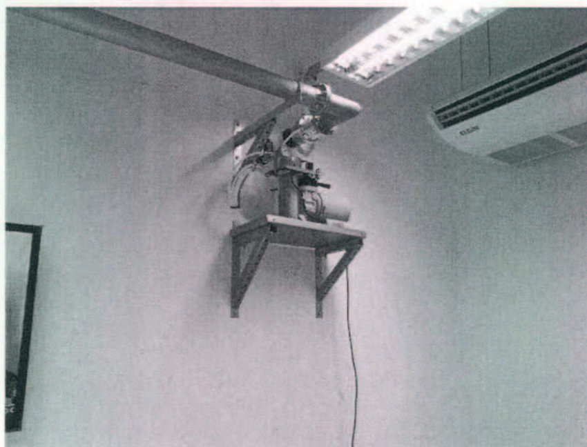
Foto 5: Pressurizador do cabo de transmissão:
