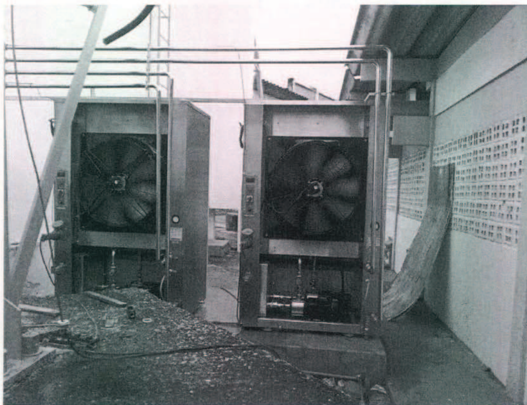
Foto 5: Pressurizador do cabo de transmissão:
