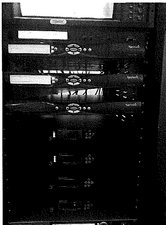
Foto 5 - Receptores de satélite e encoders
